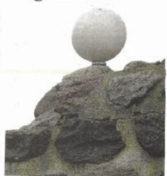
Diese weiße Kugel dient als Passpunkt für die Vermessung der Stadtmauer.
